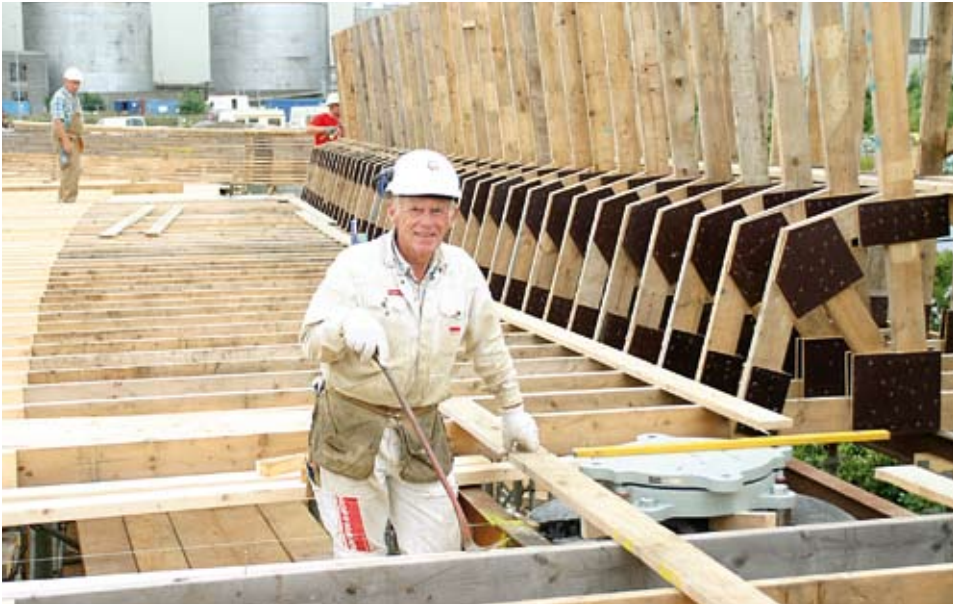
Arbejdet med et nyt banespor til Århus havn er netop gået i gang. Som det første er broforskalingen ved at blive monteret. Broen, der bygges på den tidligere Midtkraftgrund, afsluttes med en dæmning i hver ende og udføres i hvid beton med søjler af sort beton. Carl P. Blach fra MT Højgaard, som her er i gang med forskalingen, har fremstillet en model af den støbte bro i størrelsen 1:1. Modellen på billedet herunder er den ene af de to brohalvdele, hvor sporene kommer til at ligge i midten.
