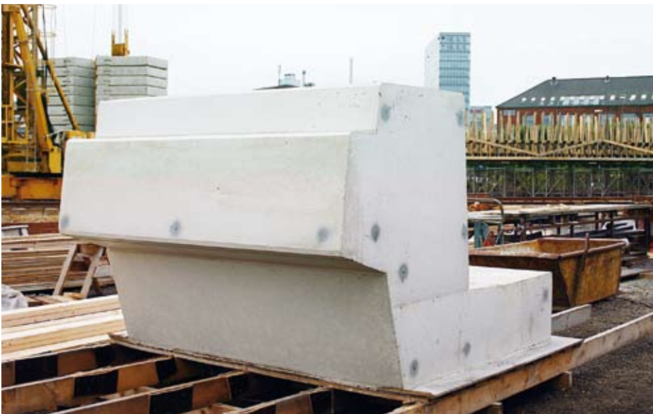
Arbejdet med et nyt banespor til Århus havn er netop gået i gang. Som det første er broforskalingen ved at blive monteret. Broen, der bygges på den tidligere Midtkraftgrund, afsluttes med en dæmning i hver ende og udføres i hvid beton med søjler af sort beton. Carl P. Blach fra MT Højgaard, som her er i gang med forskalingen, har fremstillet en model af den støbte bro i størrelsen 1:1. Modellen på billedet herunder er den ene af de to brohalvdele, hvor sporene kommer til at ligge i midten.
