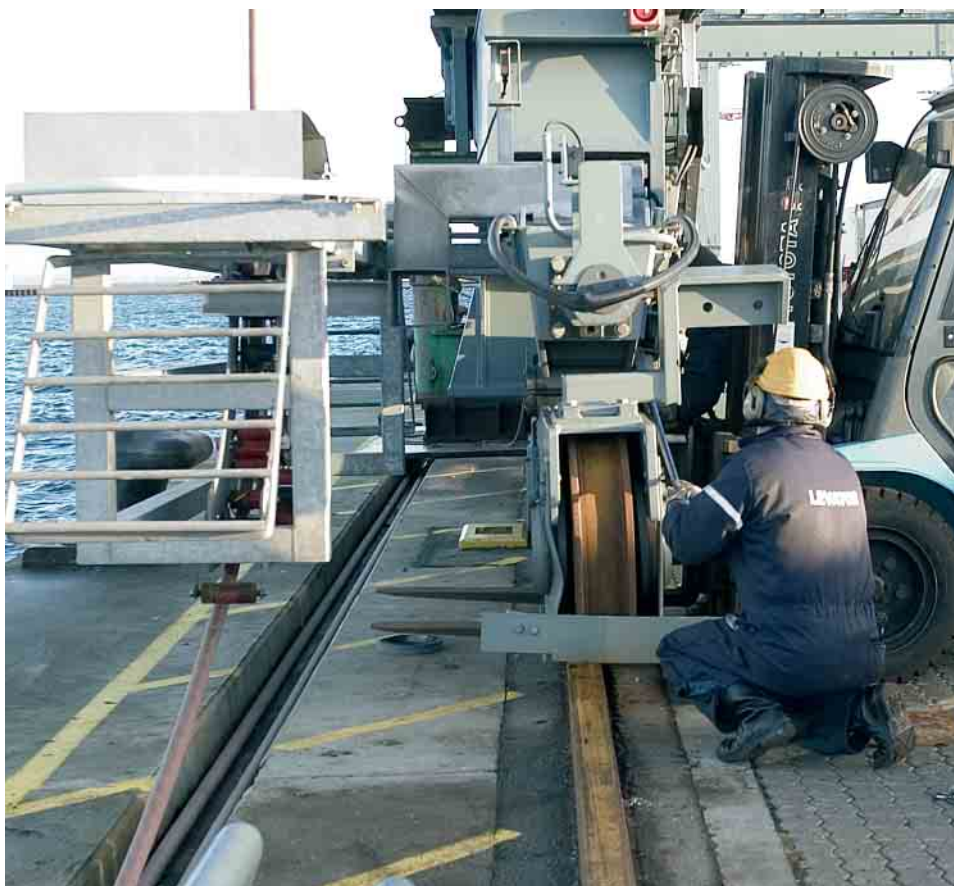
En kranetekniker fra finske Kone Cranes er her i gang med at afmontere den ene af kranens boogier, som var blevet forvredet på grund af orkanen, og som derfor skulle skiftes. Boogiens funktion er, at den huser kranens hjul.
