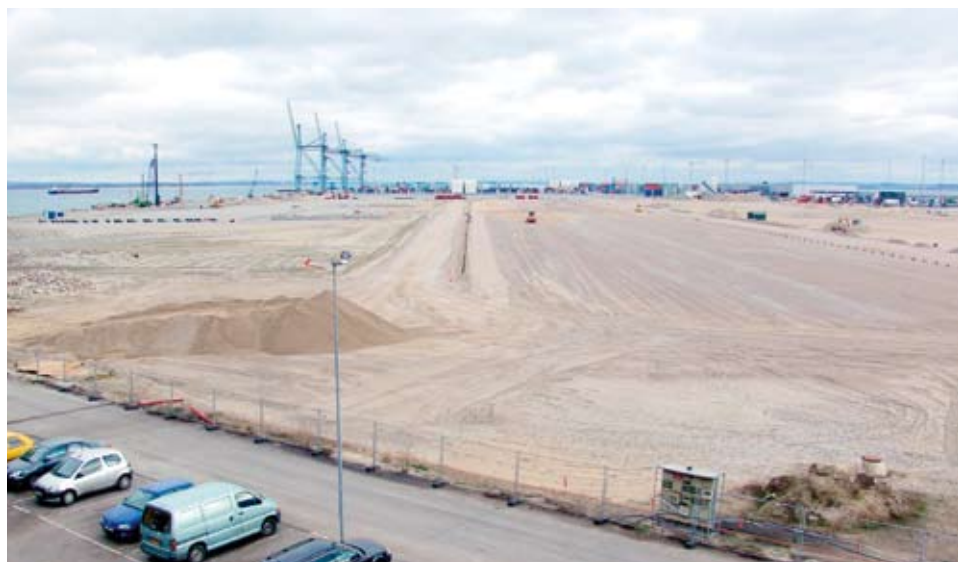
Den nye terminal til Århus Stevedore Kompagni skal ligge her. Billedet er taget fra det yderste af Bulk-terminalen. Arealet bliver på 270.000 m 2 og bliver færdig 1. maj 2007. I midten og i højre side ses rørene, som skal transportere regnvand væk fra terminalområdet.
