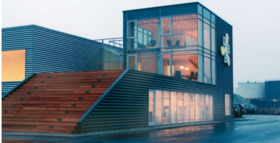
Dansk Bjergning og Bugserings nye domicil på "spidsen" af Oliehavnen – et smukt, funktionelt og maritimt nybyggeri i maritime omgivelser. Bemærk den flotte træterrasse a la skibsdæk.
